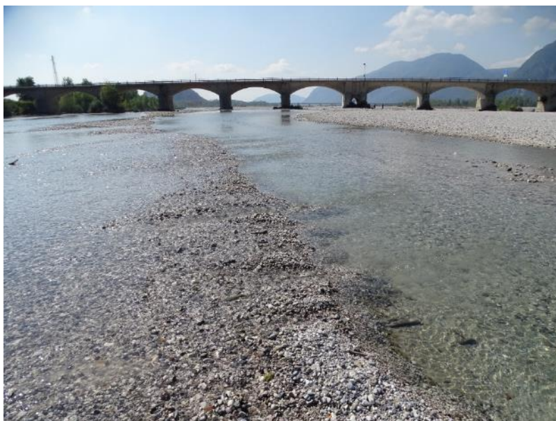
Figura 61: fotografia del canale principale della stazione "Braulins".
